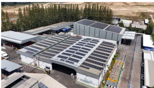
ภาพที่ 2.2-38 แผงเซลล์แสงอาทิตย์ (Solar Module) บนหลังคา (Roof Mounting) ของอาคารผลิต
