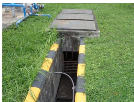
ภาพที่ 2.2-11 บ่อรวบรวมน้ำเสีย (Sump Pit)
